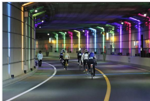
海の森トンネル（往路）
