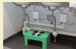
安定した踏み台を設置（荒川総合スポーツセンター）
