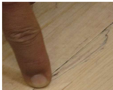
床の損傷を補修した様子
