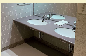
洗面台に車いすの車輪が当たらないため使用しやすい（新宿コズミックスポーツセンター）（地下1階男子更衣室）
