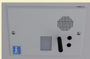
「向かって右側が車いす専用トイレです」などの案内をしてくれる人感センサー付き音声案内装置（東京体育館）
